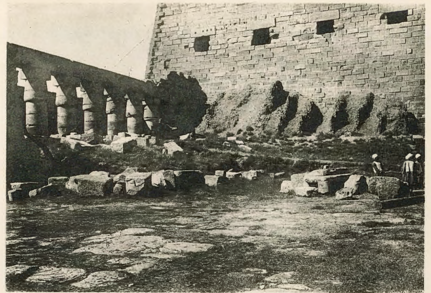
L'angle S.-O. de la Grande Cour avant le début des travaux.
